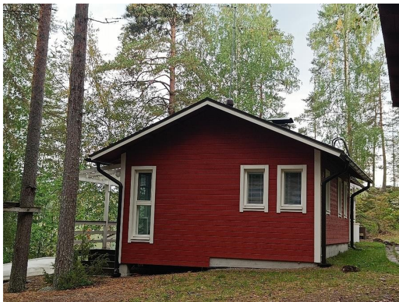
Kuva 4. Rakennuskantaa Vuoriniemen rannasta.
